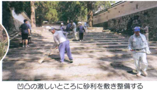
凹凸の激しいところに砂利を敷き整備する
