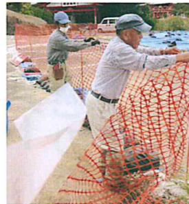
フェンスも修復
